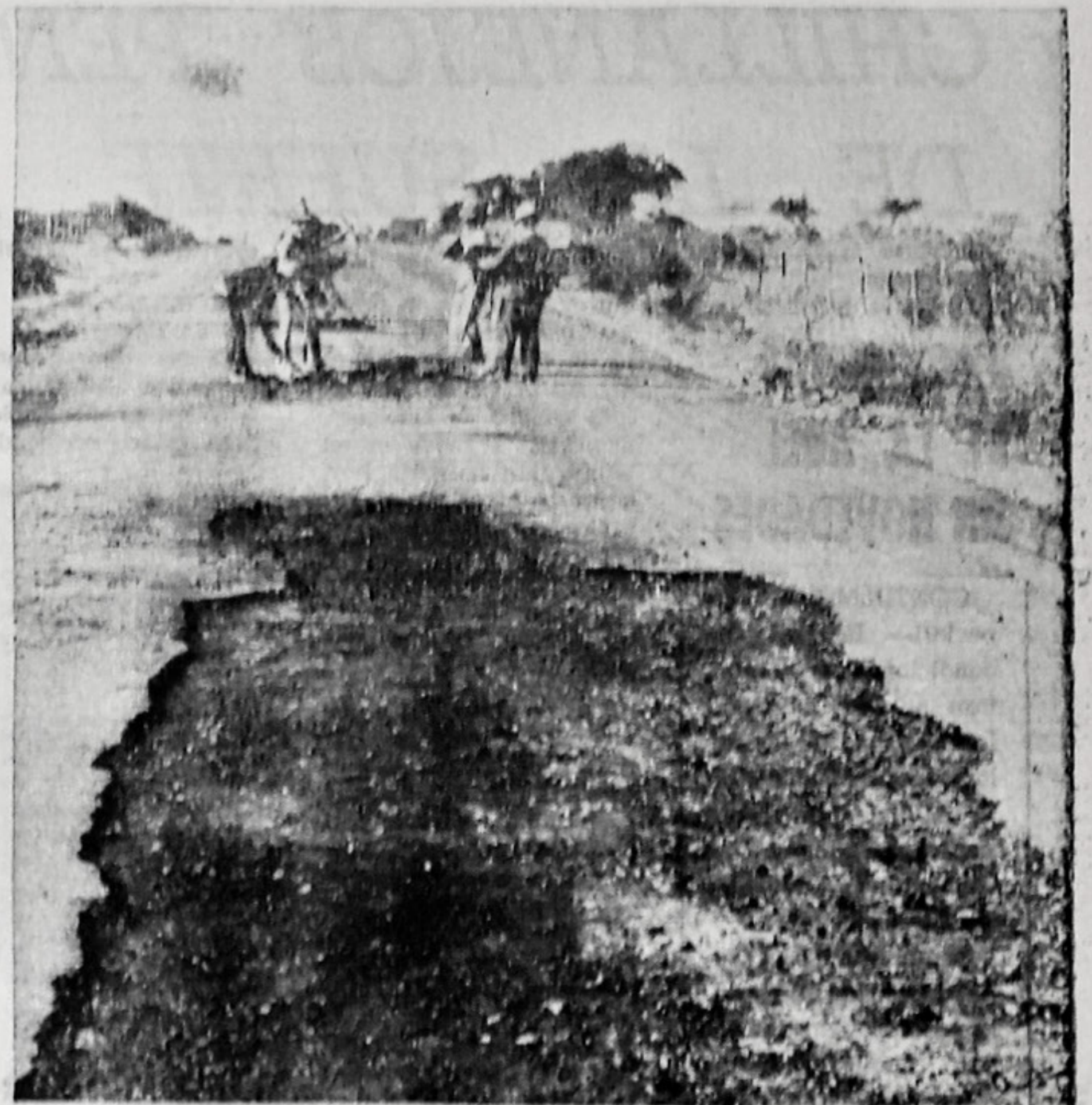
A fines de septiembre o comienzos de octubre se iniciará la colocación de un sello asfáltico en las carreteras que unen Bulnes con Quilme (camino a Concepción), y a Chillán con Coihueco. En esa misma fecha, comenzarán los trabajos de pavimentación de un tramo de 13 kilómetros del camino Chillán - Coihueco.
